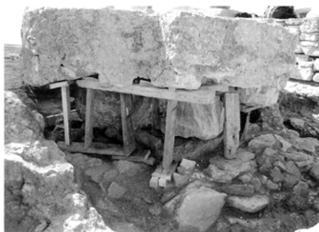
Apuntalament de tot el perímetre amb taulons de fusta
