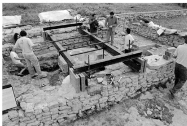
La superestructura preparada
